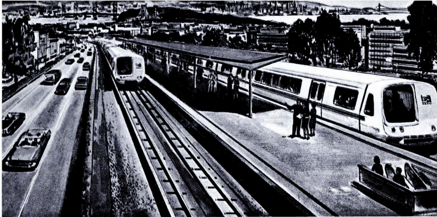
San Francisco-områdets nye intercitybaner skal fungere i nøje samspil med motorvejene. På lange strækninger anlægges banerne langs med vejene eller i midterstriben af vejene eller på en brokonstruktion herover, båret af en enkelt række søjler.
